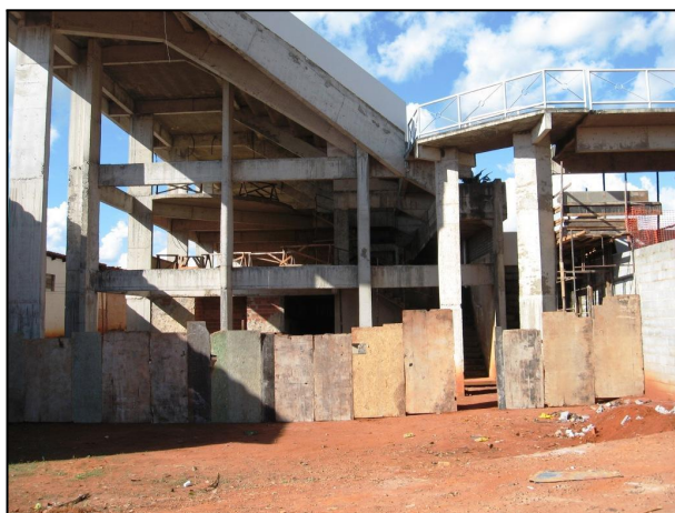
RESTARQ-0001-VAS-F50-03 - VISTA LATERAL EXTERNA DA ARQUIBANCADA PRINCIPAL AINDA INACABADA FOTO VANDERLEI ALCANTARA, 2008
