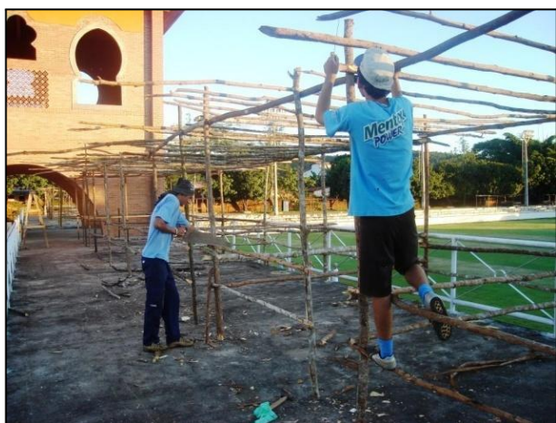
RESTARQ – 0005 – VAS-F50-05 - MONTAGEM DA ESTRUTURA DOS CAMAROTES SOBRE A LAJE E RESTARQ-0006-VAS-F50-05 – REVESTIMENTO DA ESTRUTURA DOS CAMAROTES COM FOLHAS DE PALMEIRA.
