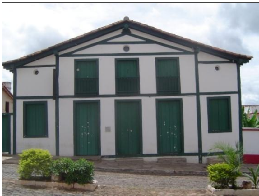
FACHADA DO THEATRO DE PYRENÓPOLIS A/D ARQUIVO ETEC-IPHAN - PIRENÓPOLIS
