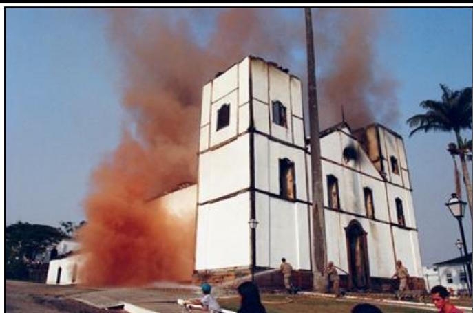
O DIA SEGUINTE AO INCÊNDIO – A/D FONTE: ARQUIVO ETEC-IPHAN – PIRENÓPOLIS, 2002
