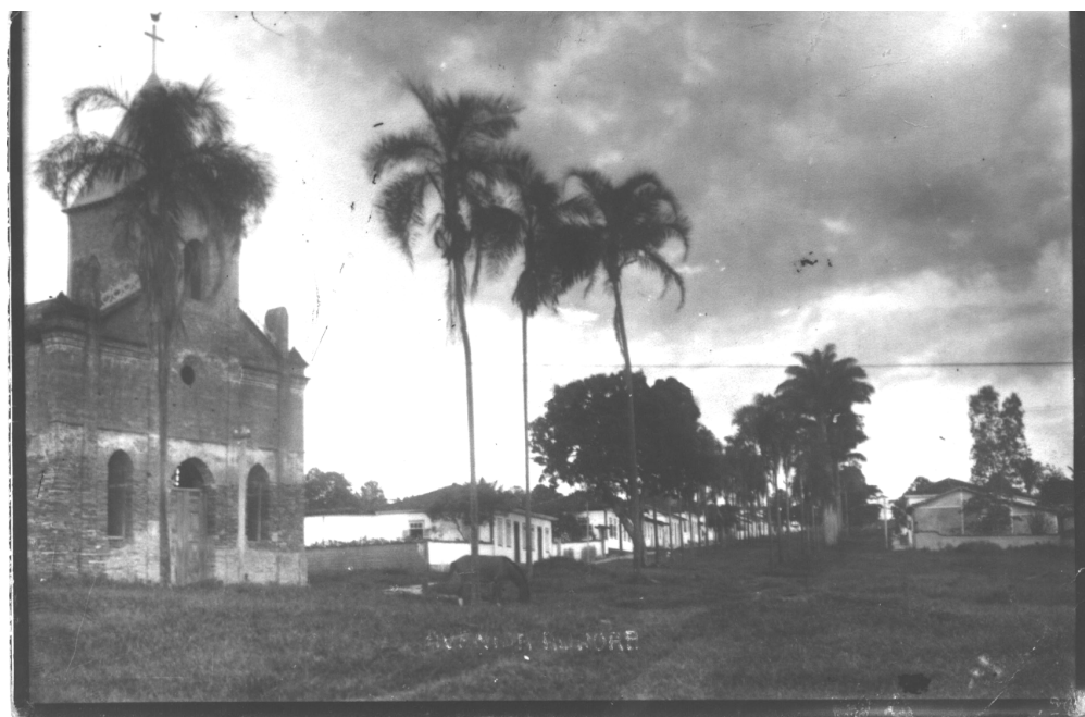
IGREJA DE NOSSA SENHORA DO ROSÁRIO DOS PRETOS POUCO ANTES DA DEMOLIÇÃO NO INÍCIO DA DÉCADA DE 1940
