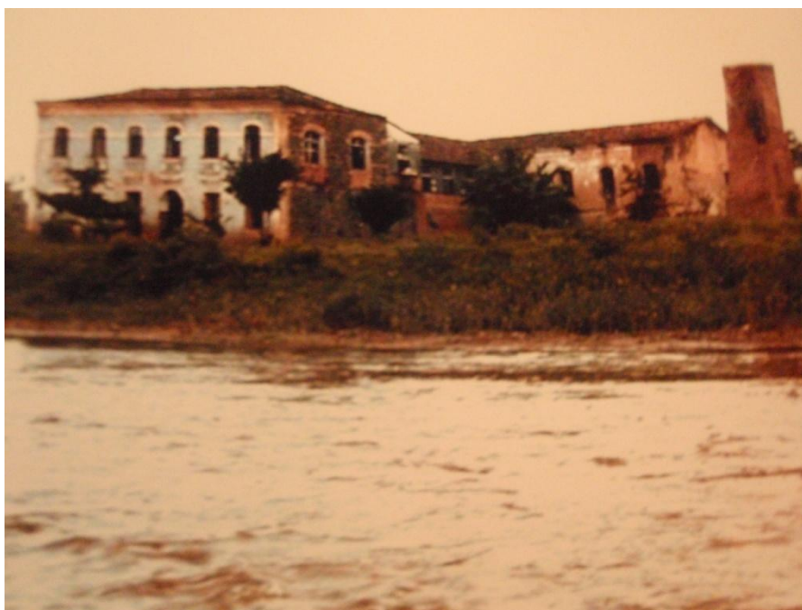
Foto do Engenho do Aproaga, antes do processo de arruinamento.
