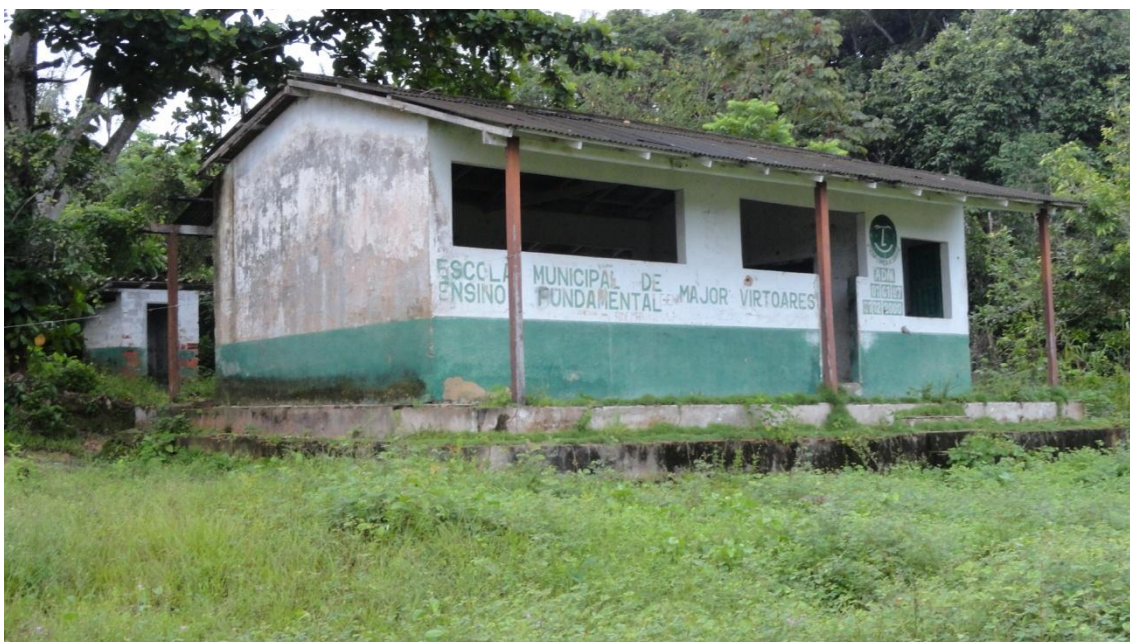
Figura 17. Escola Municipal de Ensino Fundamental desativada
