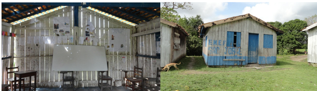
Figura 16. Exterior e interior da Escola EFM São Jorge, em Nova Vida.
