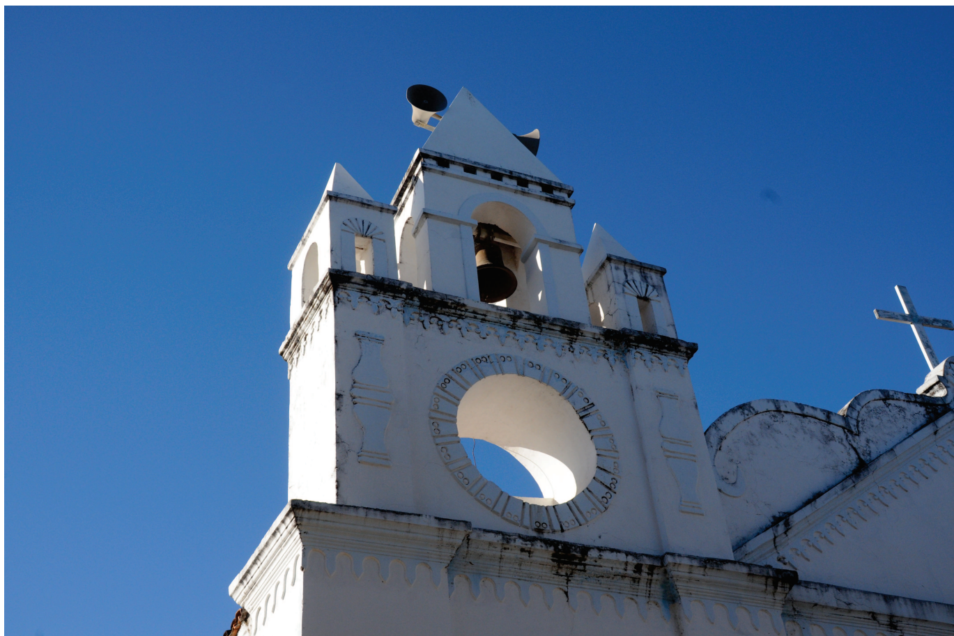
Detalhe da torre campanário da Igreja de São Domingos de Gusmão
