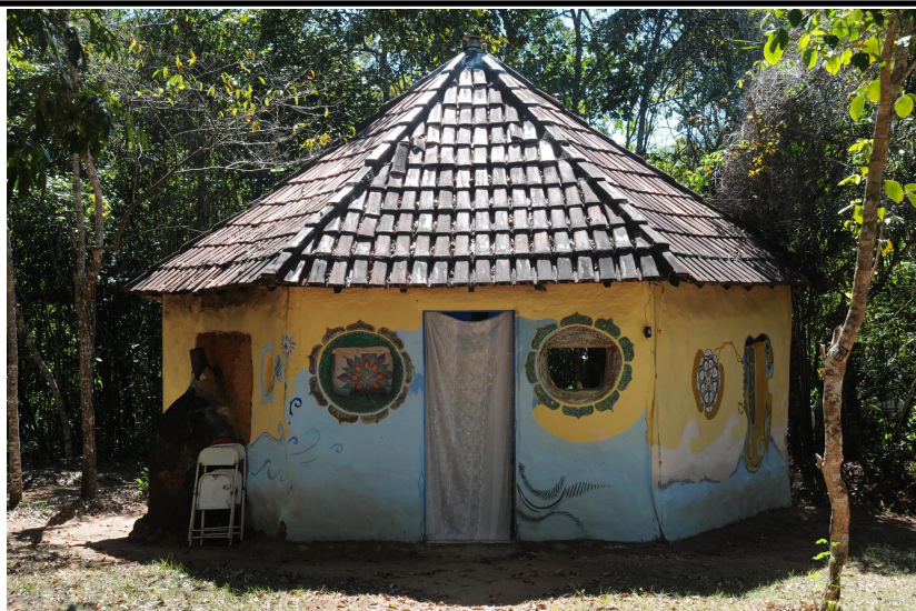
Edificação típica da Comunidade Flor de Ouro – Ligada ao Movimento Rumo ao Sol
