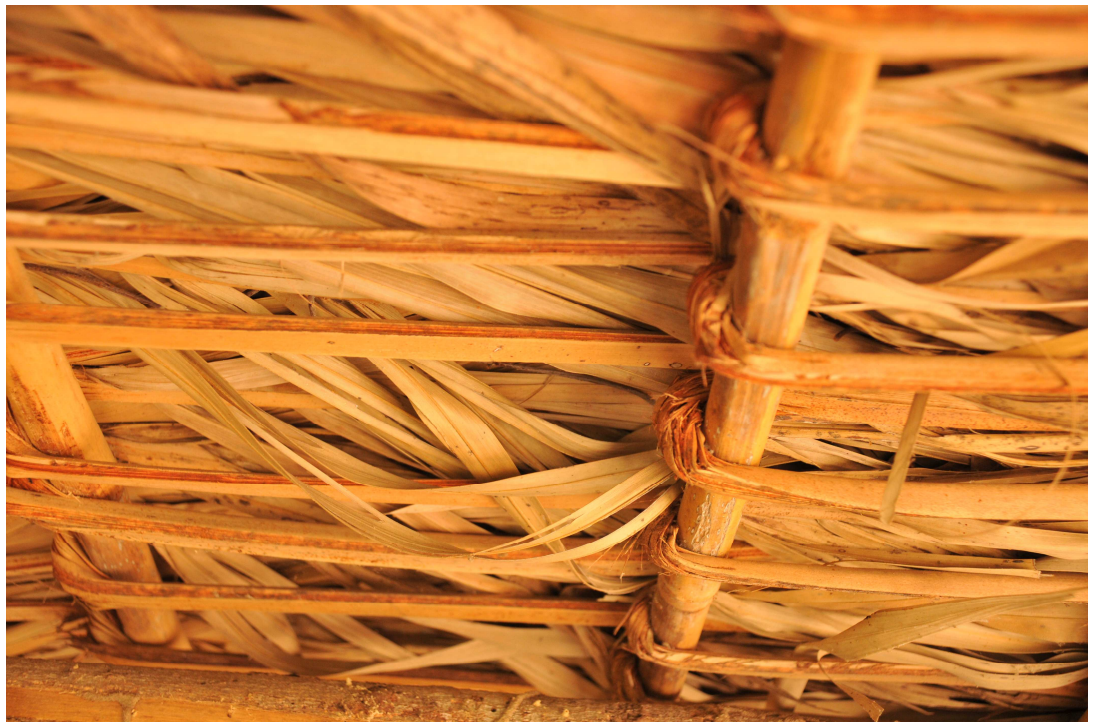
Detalhe de amarração de palha de cobertura
