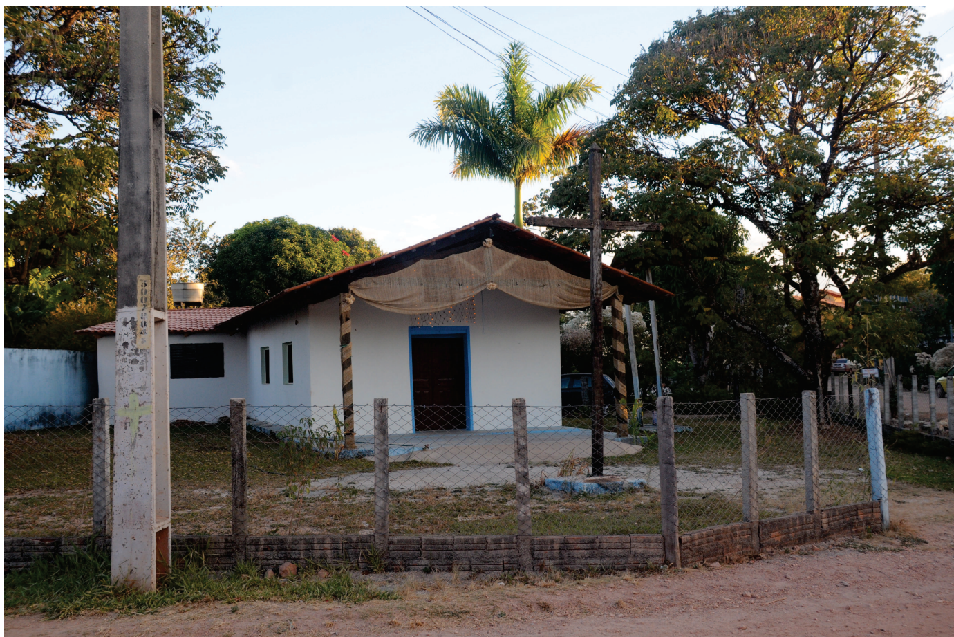
Vista panorâmica da Capela de São Jorge
