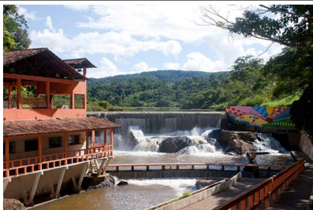
Barragem do Rio Folheta, localizada no distrito sede. Foto: Ricardo S. Gonçalves (Abril/2011)
