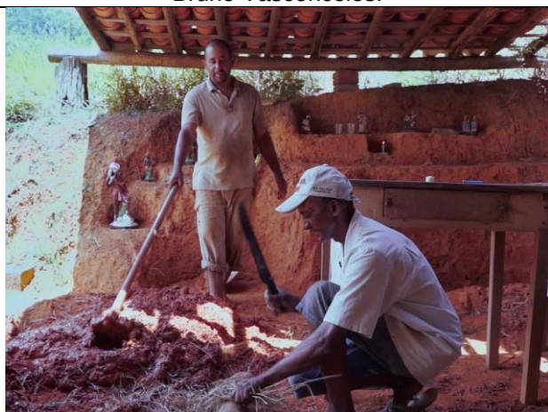
Alexandre e o pai Geraldo Milim demonstram o processo de construção. Cubas. Nov/2016. Foto Bruno Vasconcelos.
