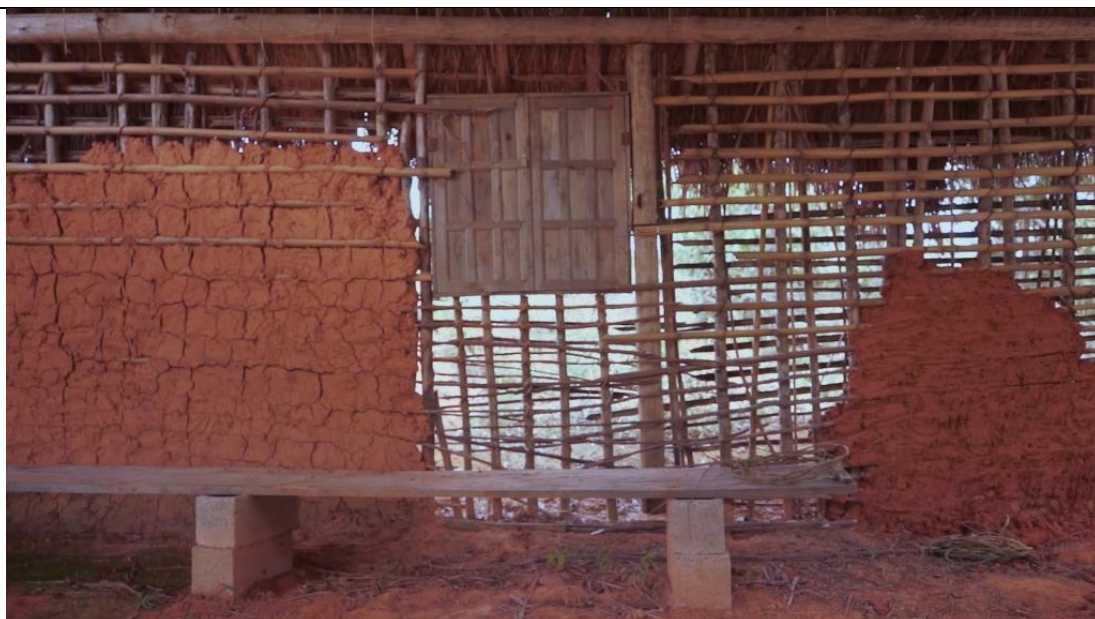
Parede em processo de finalização. A edificação será sede de uma tenda de umbanda. Cubas. Novembro de 2016. Foto Bruno Vasconcelos.
