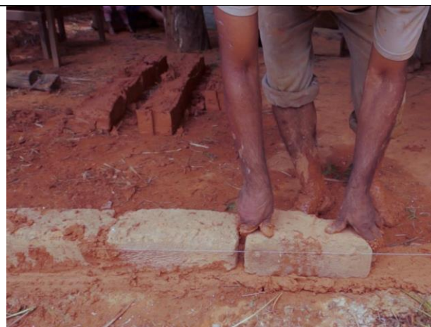
Início da construção de uma das paredes da futura tenda. Cubas. Novembro de 2016. Foto Bruno Vasconcelos.
