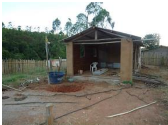
Sede da ASCAXAR – em construção. Foto: Ana Tereza Faria. Janeiro/2015
