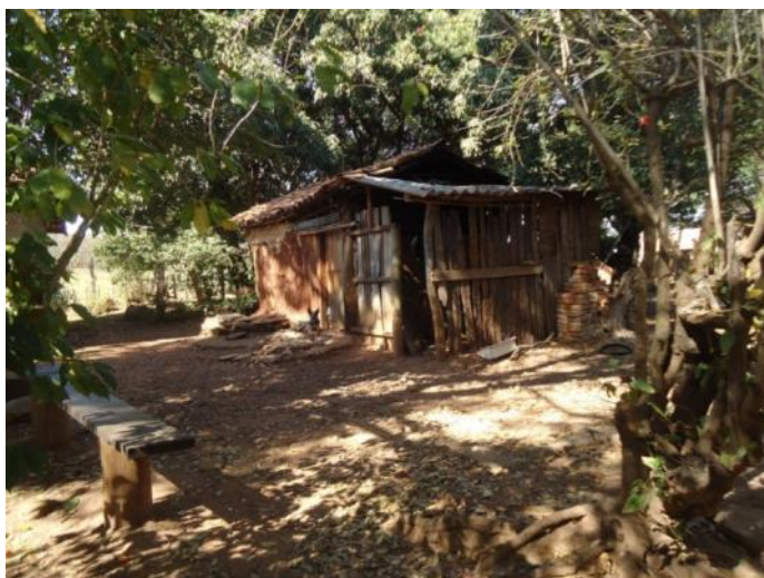
Primeira casa construída após a ação de despejo sofrida pelos herdeiros de Bil e Rita. Açude (Comunidade Quilombola do Açude). Ana Tereza Faria. Julho/2015.
