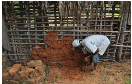
Alvenaria em barro. Jan/2017 Foto: Bruno Vasconcelos
