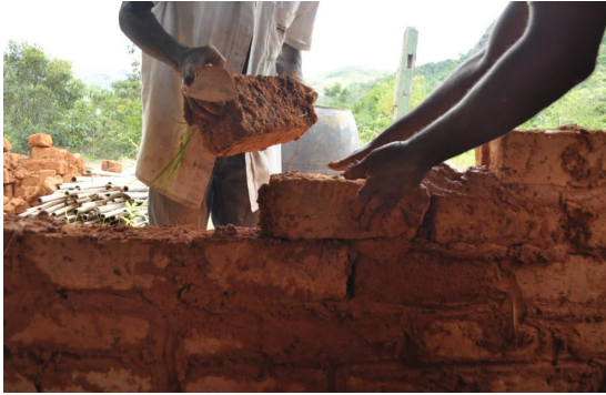
Alvenaria em barro. Jan/2017 Foto: Bruno Vasconcelos
