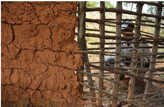
Alvenaria em barro. Jan/2017 Foto: Bruno Vasconcelos
