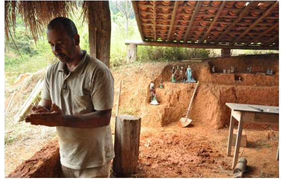
Alvenaria em barro. Jan/2017 Foto: Bruno Vasconcelos
