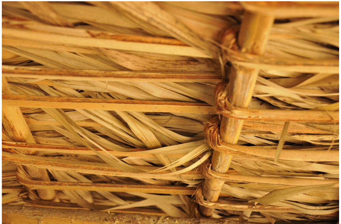
Detalhe de amarração de palha de cobertura
