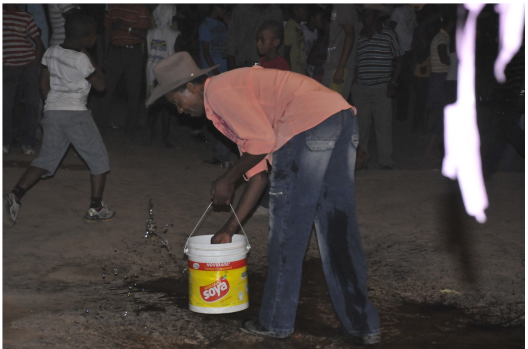
Imperador molhando piso de cimento
