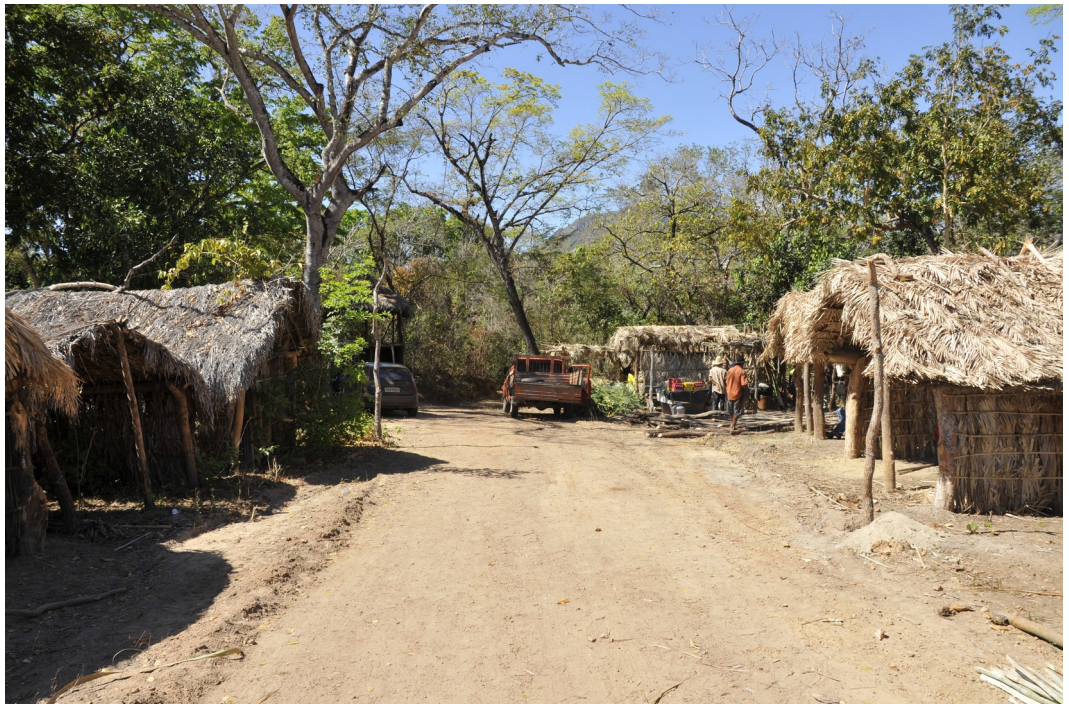
Ranchos de palha de uso comercial, avenida de acesso ao rio
