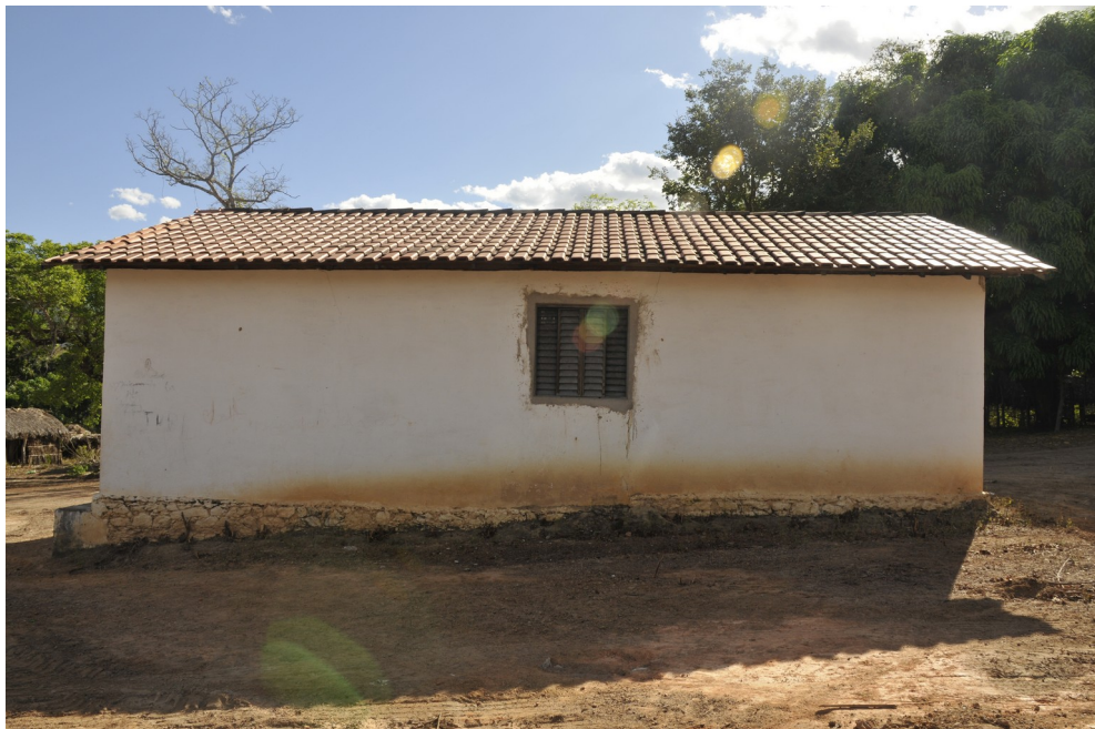
Fachada Lateral Direita
