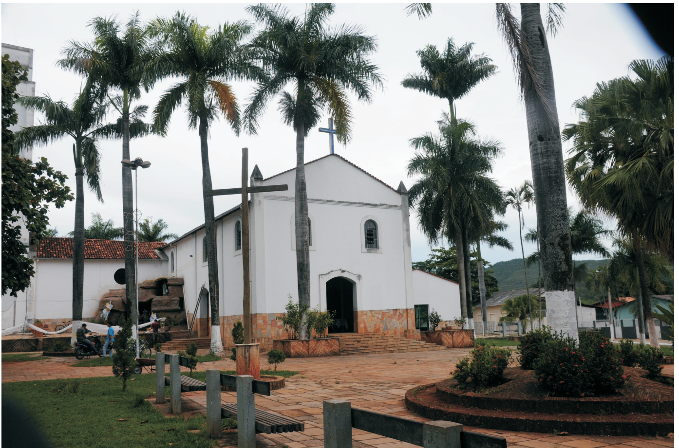
Parte posterior da Igreja de São José
