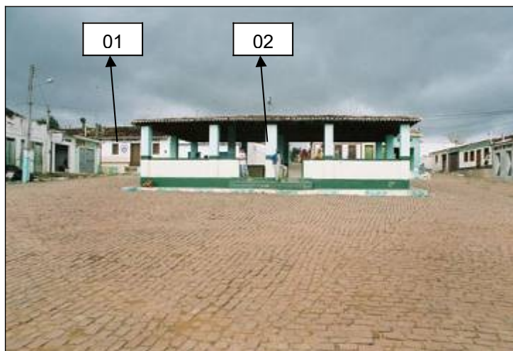
Foto 06. Praça Gerson Novais. (01) Indicação de um dos lugares utilizados outrora como “depósito” de café e abrigo de tropeiros e (02) indicação do “barracão” (F1-A2 1966).
