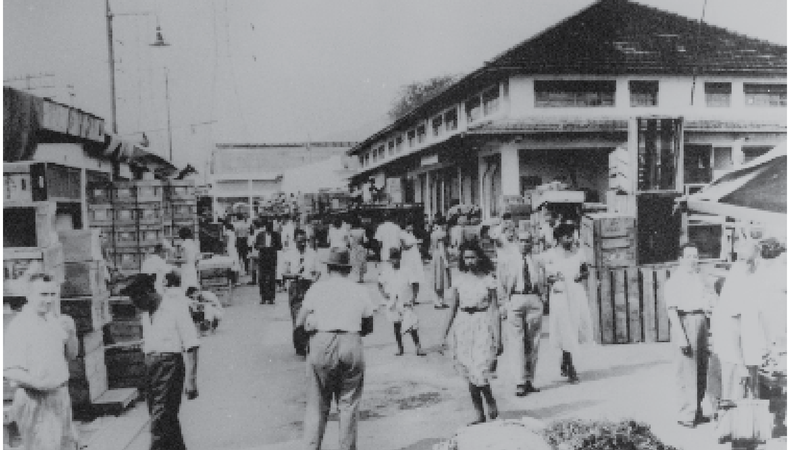
Mercado de Madureira – 1954. O crescimento provocou a falta de espaço para armazenamento, resultando no empilhamento de embalagens pelas alamedas. Sem eficiente serviço de apoio não há presteza na retirada de lixo
