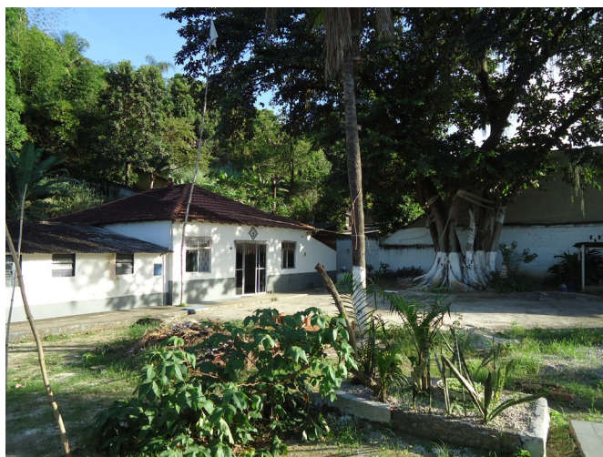
Foto DSC00185 – vista da entrada do barracão
