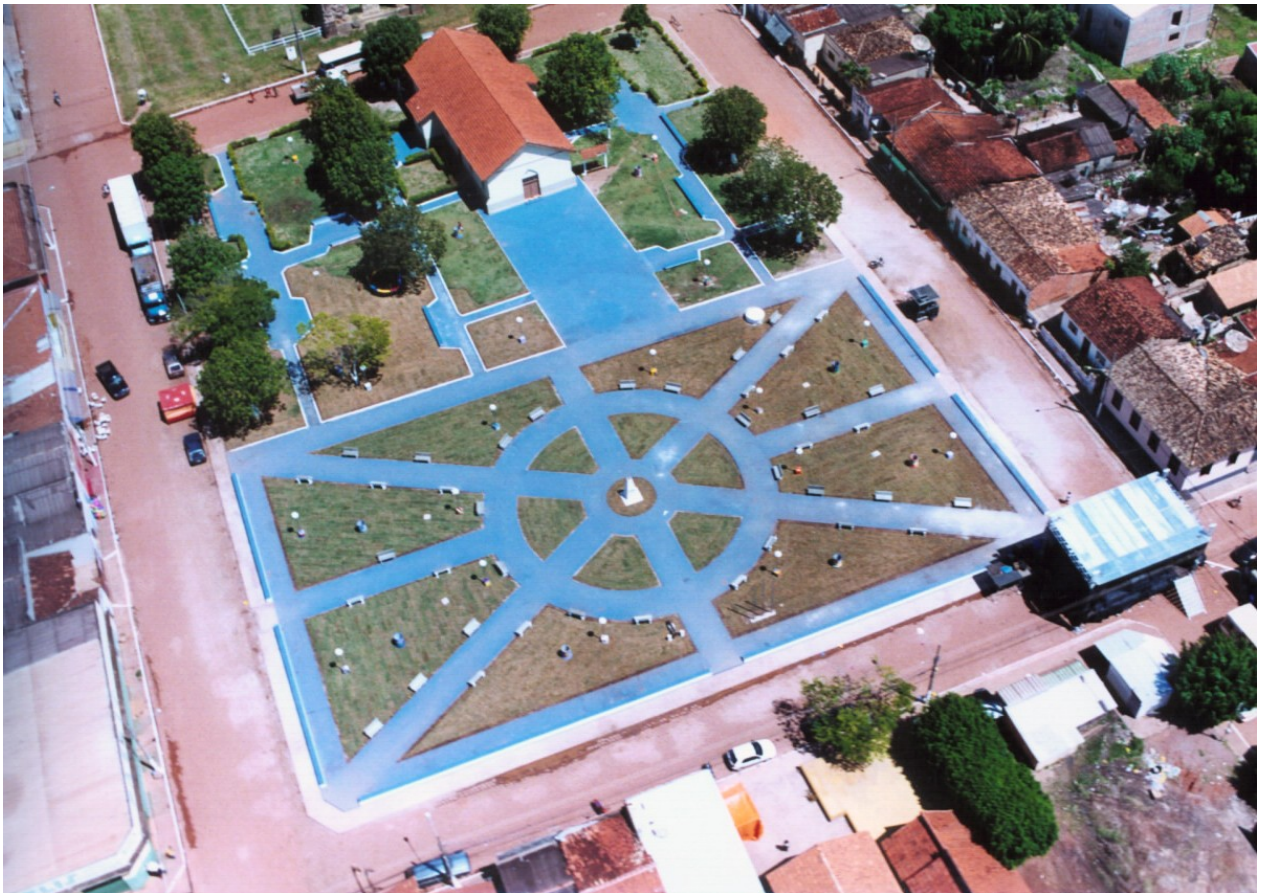
Vista aérea da praça principal e a Igreja Matriz. No pátio frontal da Igreja, é que ocorre a apresentação do Chorado e do Congo, assim como o levantamento dos mastros. Embaixo à direita, na esquina da rua Pouso Alegre com a rua Travessa do Palácio, o palco para a realização de shows musicais. (006)
