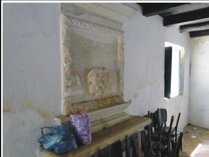
Legenda: Bica de pedra entalhada, na sacristia Foto: Fernando Montenegro (dez/10)
