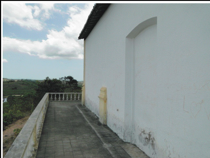
Legenda: Calçada e parte da fachada lateral Fonte: Fernando Montenegro (dez/10)
