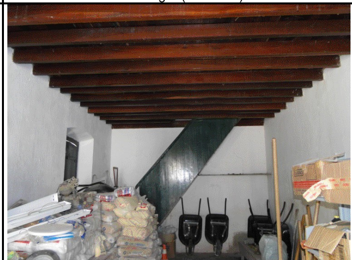
Legenda: Acesso ao pavimento superior da sacristia Fonte: Fernando Montenegro (dez/2010)
