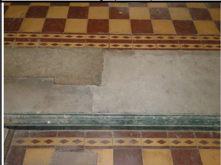
Legenda: piso da nave, soleira e piso da capela-mor Fonte: Fernando Montenegro (dez/2010)
