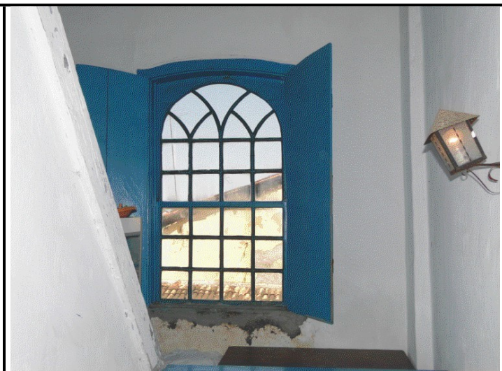
Legenda: Vista interna de janela do pavimento superior voltada para o quintal Foto: Fernando Montenegro (Dez/2010)
