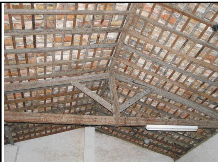
Legenda: Detalhe da estrutura da coberto do anexo Foto: Fernando Montenegro (Dez/2010)
