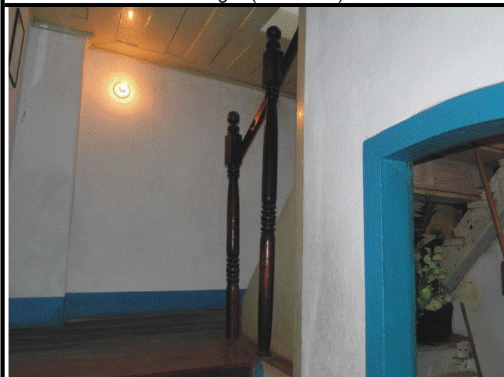
Legenda: Detalhe do guarda-corpo da escada Foto: Fernando Montenegro (Dez/2010)
