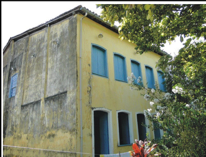
Legenda: Vista posterior do edifício Foto: Fernando Montenegro (Dez/2010)
