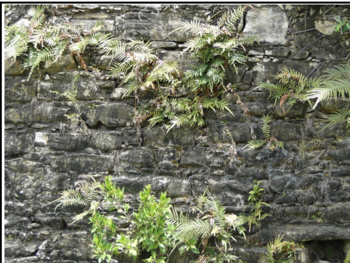
Legenda: Detalhe da estrutura das cabeceiras, em pedras Foto: Fernando Montenegro (Dez/2010)
