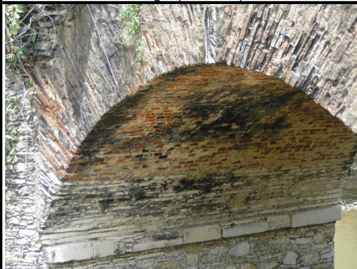
Legenda: Detalhe da estrutura das abóbadas em tijolos cerâmicos Foto: Fernando Montenegro (Dez/2010)
