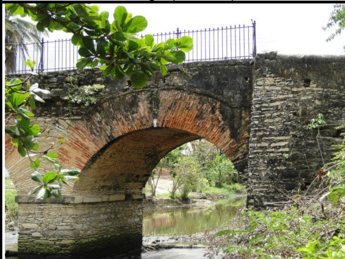
Legenda: Detalhe da estrutura: abóbadas e cabeceiras Foto: Fernando Montenegro (Dez/2010)
