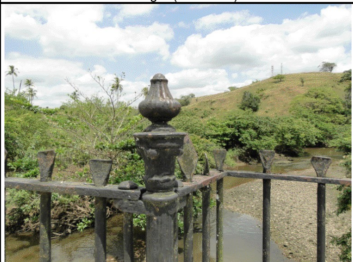
Legenda: Detalhe do gradil do guarda-corpo Foto: Fernando Montenegro (Dez/2010)
