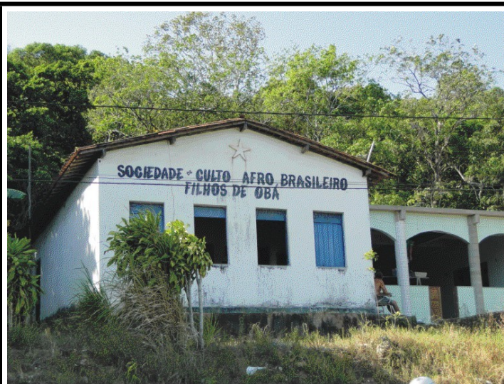
Legenda: Edifício sede Foto: Fernando Montenegro (Dez/2010)
