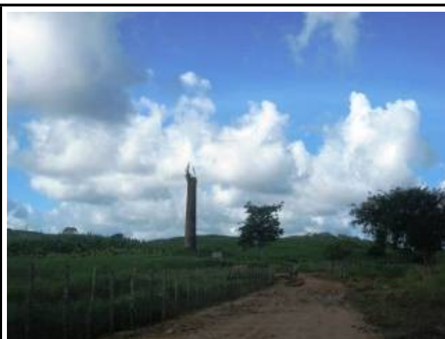
Chaminé da ruína do Engenho Pilar Foto: Klaus Brendle (2010)
