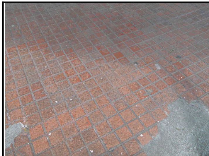
Piso do coreto Foto: Fernando Montenegro (Dez/2010)
