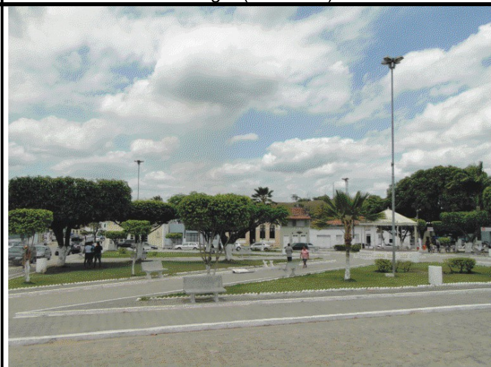
Vista geral Foto: Fernando Montenegro (Dez/2010)
