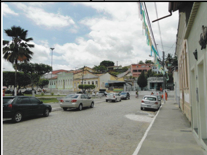
Casario do entorno Foto: Fernando Montenegro (Dez/2010)
