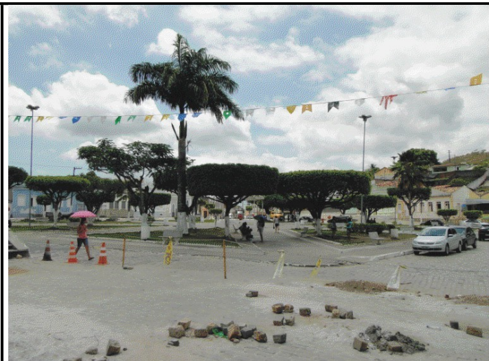
Vista geral e entorno Foto: Fernando Montenegro (Dez/2010)
