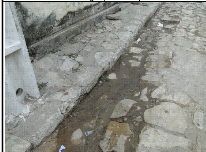
Detalhe da pavimentação da via e da calçada na Traversa Liberdade Foto: Fernando Montenegro (Dez/2010)
