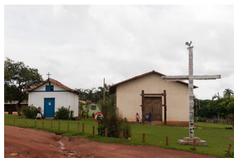
Santana_do_Riacho-7.jpg Capelas de São Sebastião - Lapinha da Serra, Santana do Riacho
