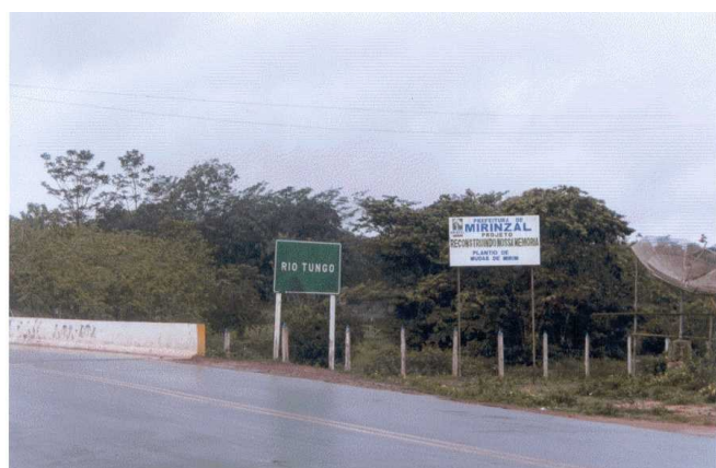
Foto 01: Ponte sobre o Rio Tungo, na entrada da cidade de Mirinzal MA
