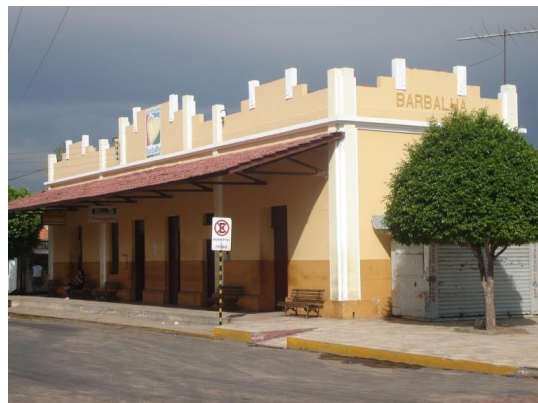
ESTAÇÃO FERROVIÁRIA DE BARBALHA, JANEIRO DE 2008 FONTE: INVENTÁRIO DO PATRIMÔNIO FERROVIÁRIO DO CEARÁ – IPHAN-CE
