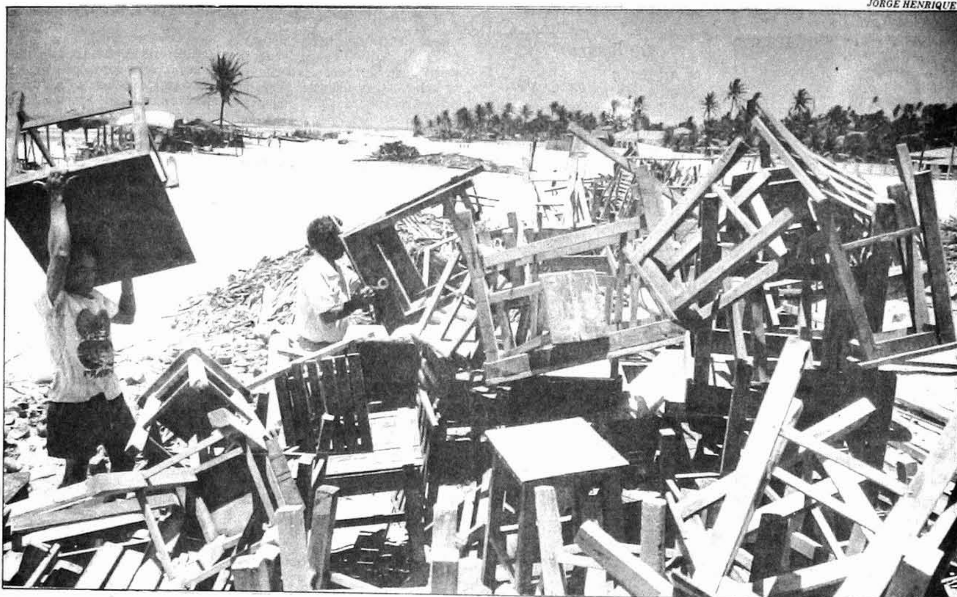
Mar furioso destruiu dezenas de barracas na Prainha e o que sobrou está sendo amontoado na parte mais alta do local
