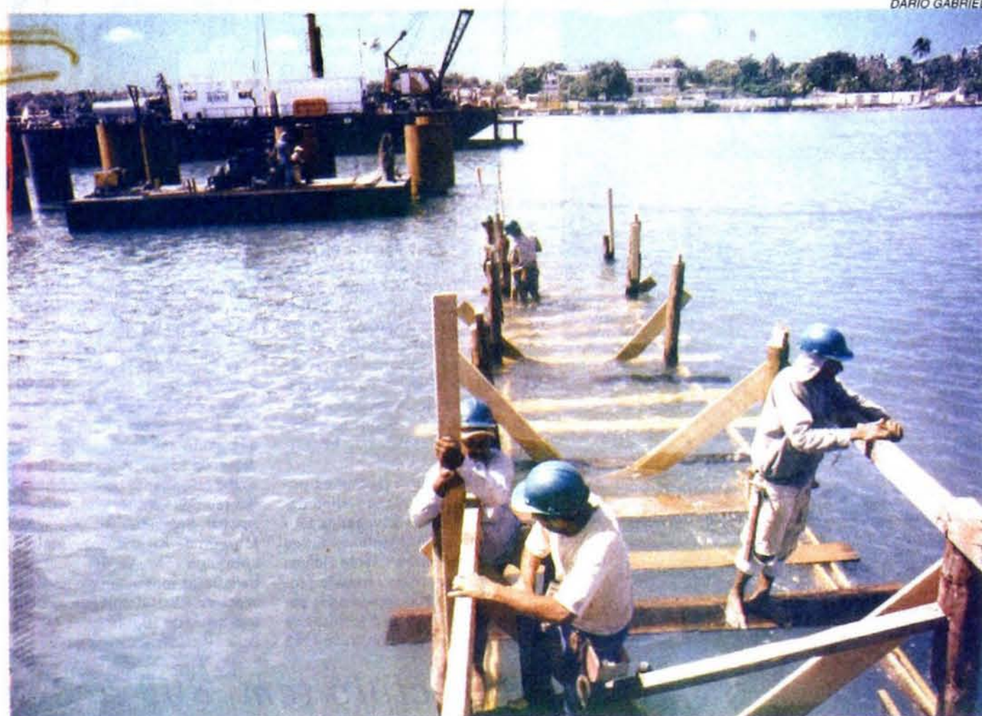
PONTE - A Sumov anuncia que 25% das obras de construção da ponte que vai interligar a Barra do Ceará às praias da Zona Oeste, já estão em fase de conclusão e promete entregar a ponte em 16 de dezembro deste ano. 2E
