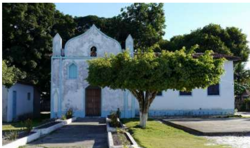
Capela de Sant'Ana, Bairro de Santana, Conceição da Barra-ES.
