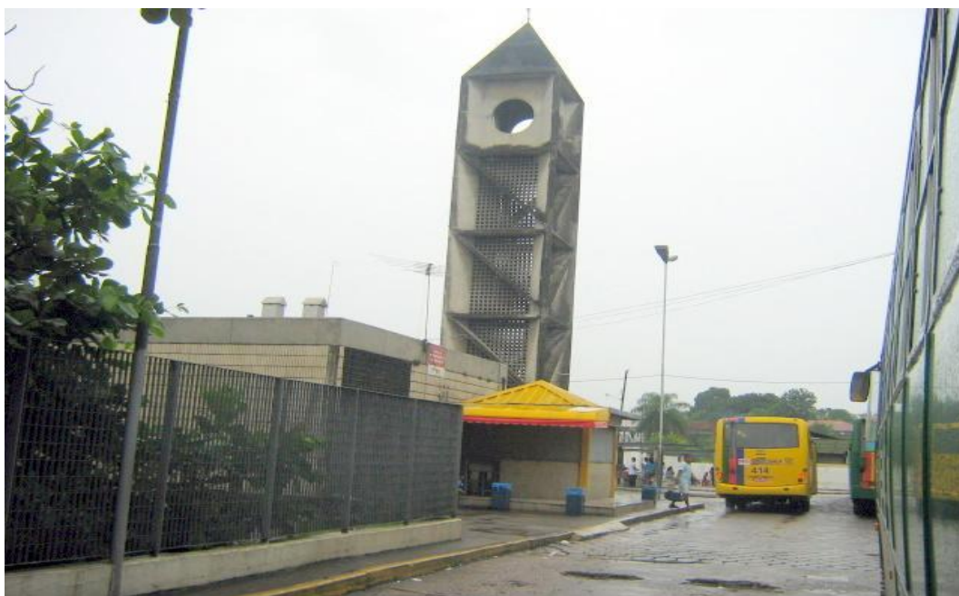
Foto 4: Jaboaão Centro: estação terminal do trem.
