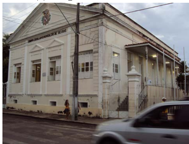
Registro IC05.01_0983: Aspectos da localidade: Grupo Escolar Dom Romualdo de Seixas, erguido em 1905. Fonte : Equipe INRC_Carimbó, maio de 2011
