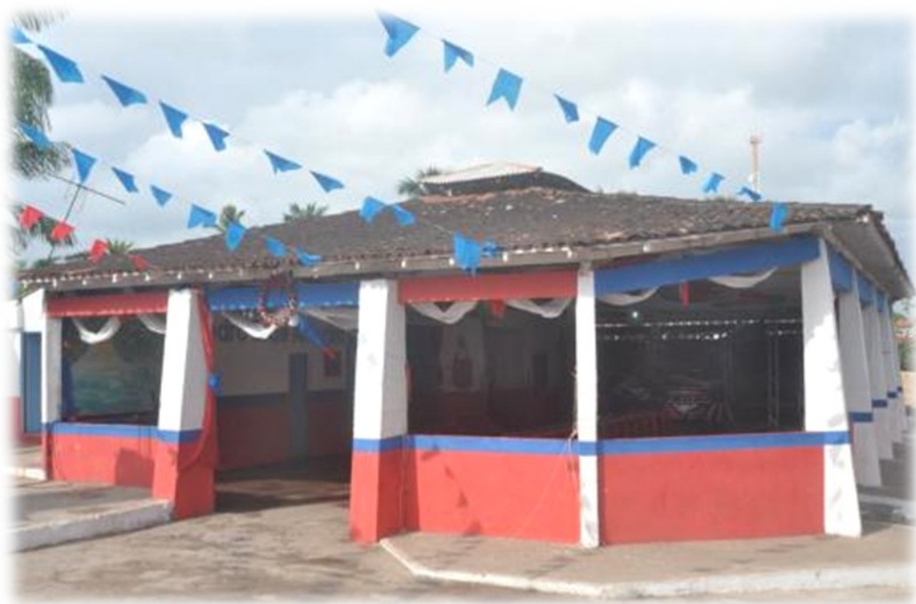
Figura 20 Barracão da Marujada de Quatipuru
