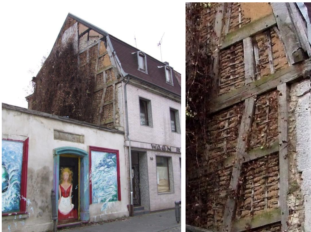
Casa em Enxaimel em Königswinter, Alemanha. À direita, detalhe do preenchimento. Königswinter, Alemanha, 2008. Foto: Liliane Corrêa
