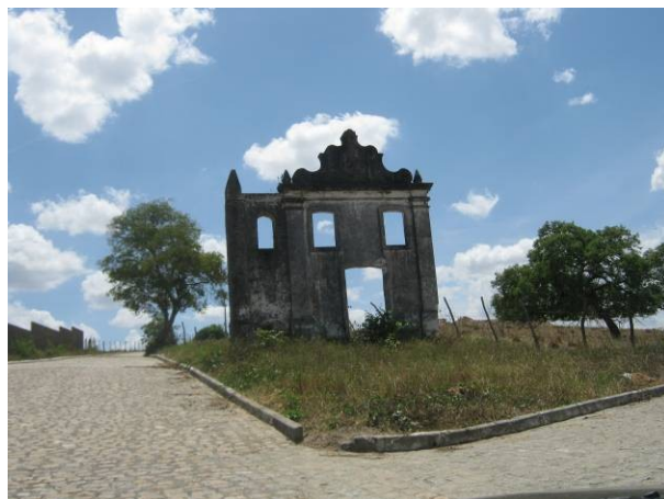
Foto 14: Igreja em ruína, Telha.
