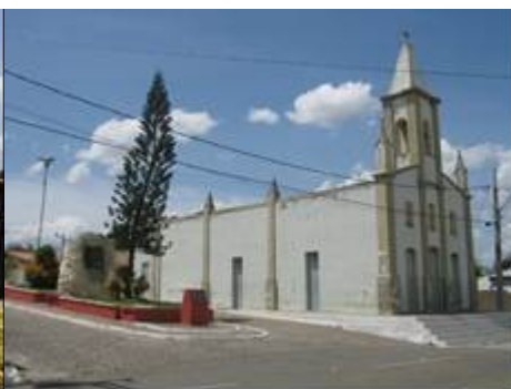
Foto 08: Telha - Igreja Matriz Nossa Senhora do Perpétuo Socorro. Foto Digital – Eder Souza, junho de 2012.
