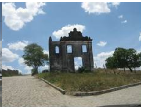
Foto 09: Telha - Igreja em ruína. Foto Digital – Eder Souza, fevereiro de 2012.
