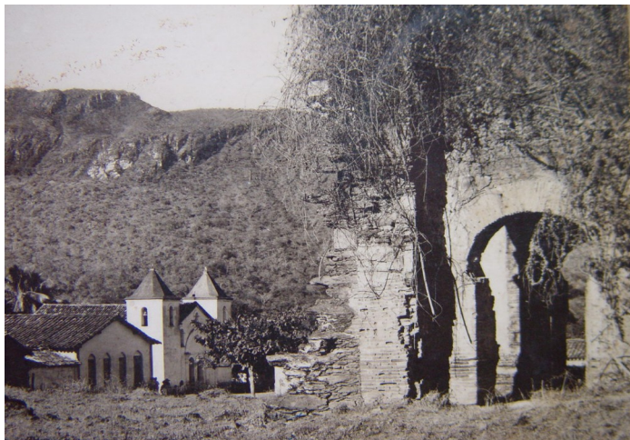
F 1 Vista da Ruína da Igreja Matriz, da casa de Aquina e da Igreja da Matriz, a ruína coberta por vegetação. TO010007F30nº21 F12
