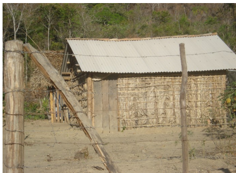
F4 edificações TO010007F50A2 nº 15 F7
