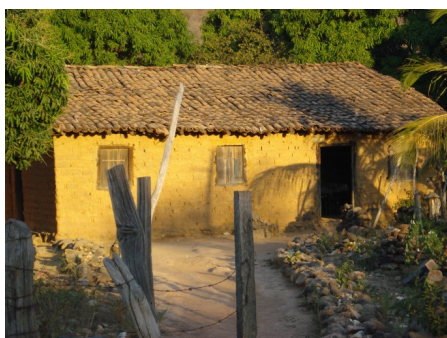
F5 edificações TO010007F50A2 nº 15 F10
