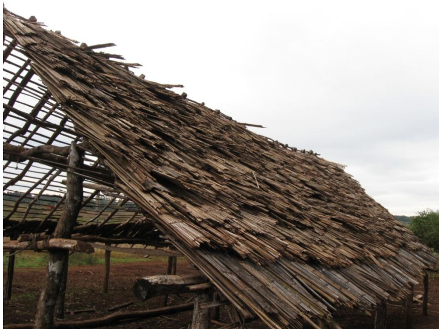
OPY EM CONSTRUÇÃO NA ALDEIA KO'ÊJU COM COBERTURA DE TAKUA PEKURU . 2010
