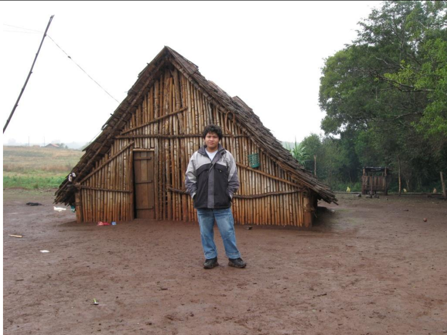
CASA TRADICIONAL COM COBERTURA E PAREDES DE TAQUARUÇU ( TAKUA PEKURU ). ALDEIA KO'ÊJU. SÃO MIGUEL DAS MISSÕES. RS. 2010.
