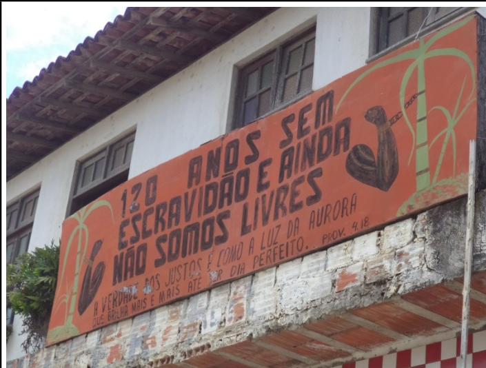
Imagem 12: Placa fixada em uma edificação no Conjunto Manoel do Prado Franco, município de Laranjeiras/SE. Foto: Raul Lanari. Data: Abril/2016.
