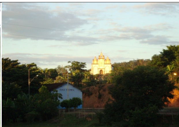
Foto 06: Vista do Prédio da antiga Estação Ferroviária e da Capela de São Domingos. Foto de Luiz Henrique Rodrigues. Abril de 2013
