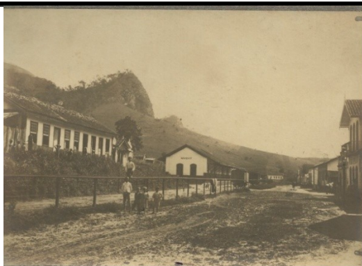
Foto 1: Estação ferroviária. São João do Muqui. Município de Cachoeiro do Itapemirim. Fonte: IPHAN (Espírito Santo).
